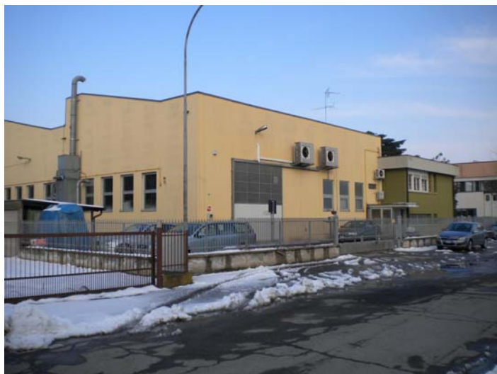
Immagine del fronte Sud dello stabilimento
