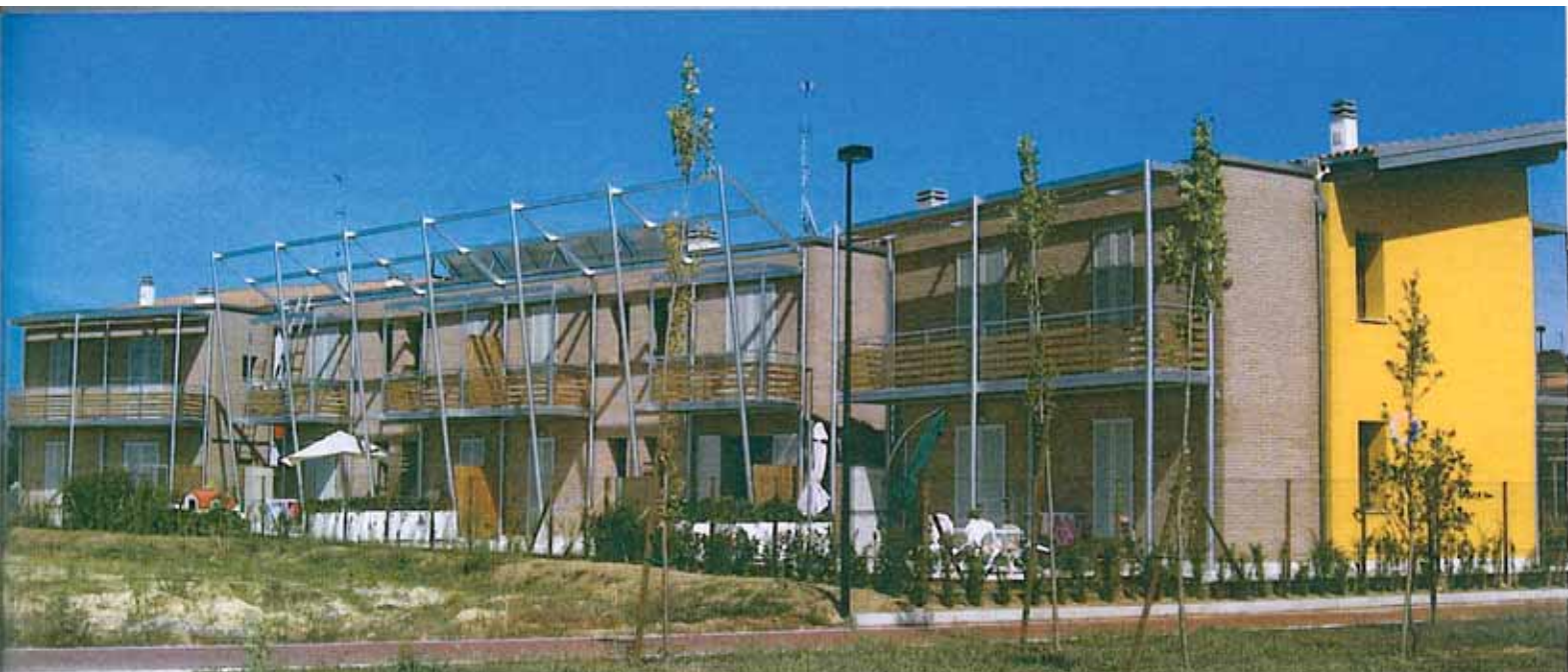
Prospetto nord dell'edificio residenziale "SHE.AG1", 8 alloggi (A. Mingozzi / COPES).
